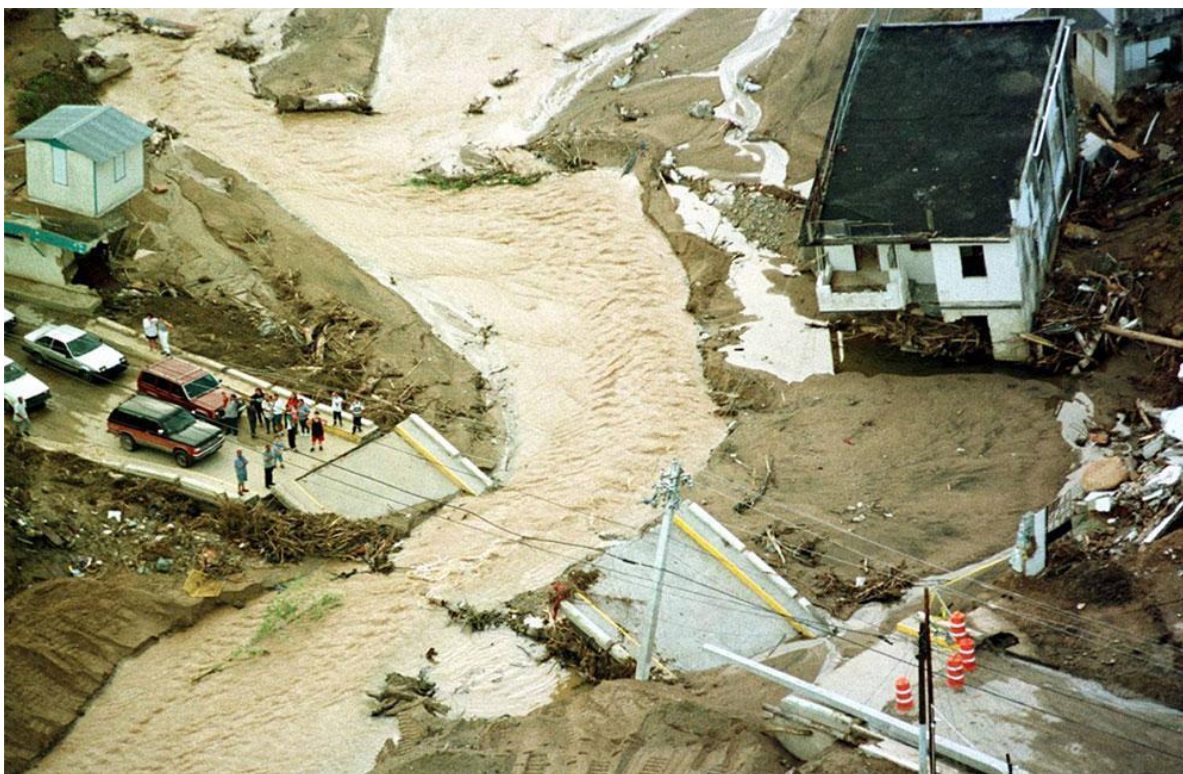
Inundaciones ocurridas por el azote del Huracán Georges (1998) en Puerto Rico. La fuerza de las corrientes de los ríos destruyeron puentes, caminos vecinales y edificios (imagen de FEMA).
