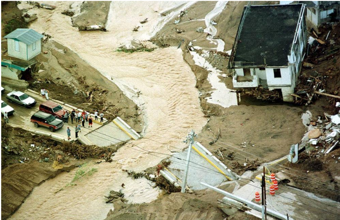
Inundaciones ocurridas por el azote del Huracán Georges (1998) en Puerto Rico. La fuerza de las corrientes de los ríos destruyeron puentes, caminos vecinales y edificios (imagen de FEMA).
